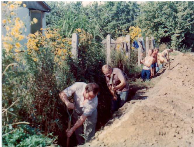
Graben für Wasserleitung und Stromkabel
